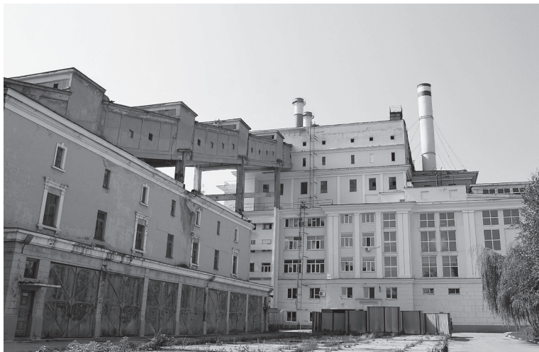
Вид на Самарскую ГРЭС со стороны угольной галереи
