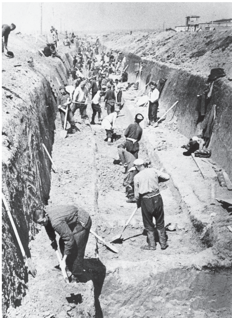
Фотографии строительства Безымянской ТЭЦ
