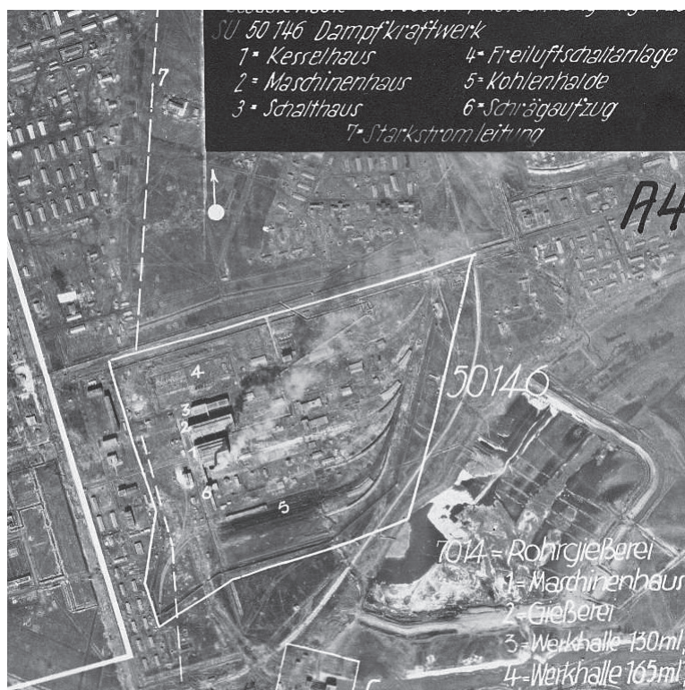
На снимке, сделанном германским самолетом-разведчиком, не только виден дым из трубы Безымянской ТЭЦ, но и подписано расположение цехов станции
